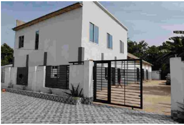
Kerkgebouw van de achterkant
